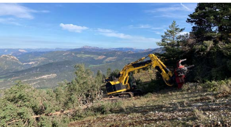
Travaux de réouverture de pâturage à Valdrôme
