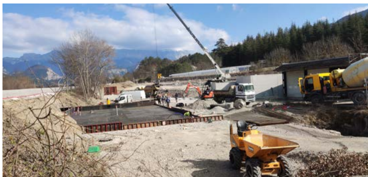
Les travaux à l'aire de tri de Die
