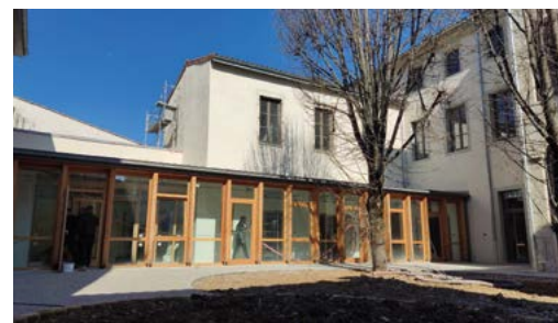
Visite des travaux du Pôle Enfance à Die
