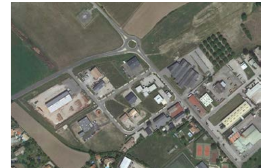
Mars 2023, l'ensemble des lots disponibles de la partie Sud sont vendus. Les travaux d'aménagement de la partie Nord démarrent en juin 2023.
