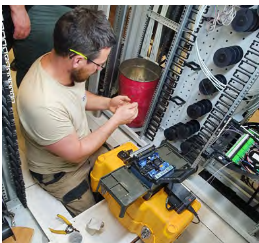
▲ Soudure des fibres optiques
