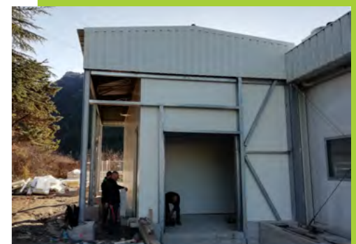
Travaux extension chambre froide
