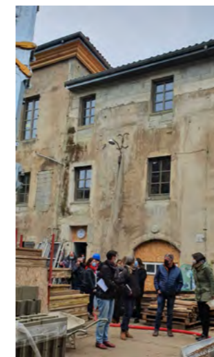
Visite des travaux du Pôle Enfance à Die
